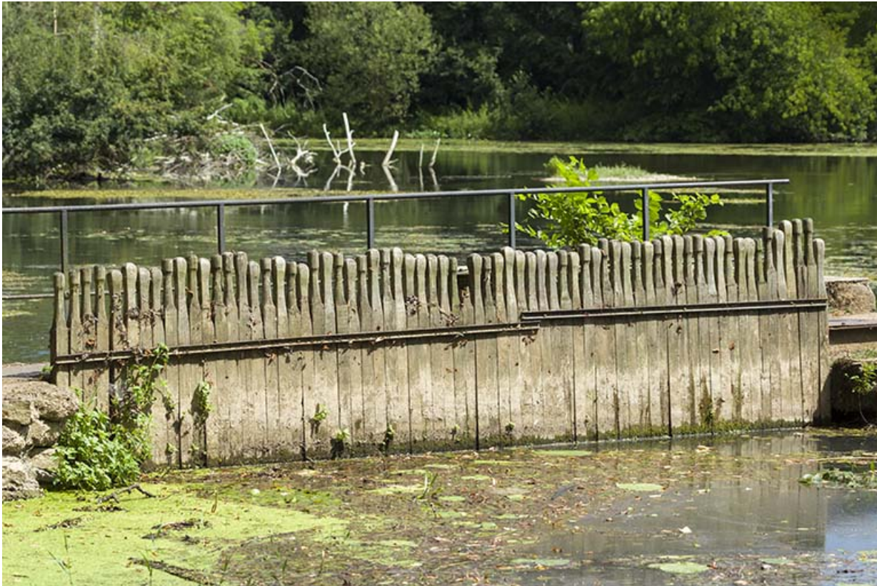
Aiguilles fermant l'ancien pertuis de navigation.
