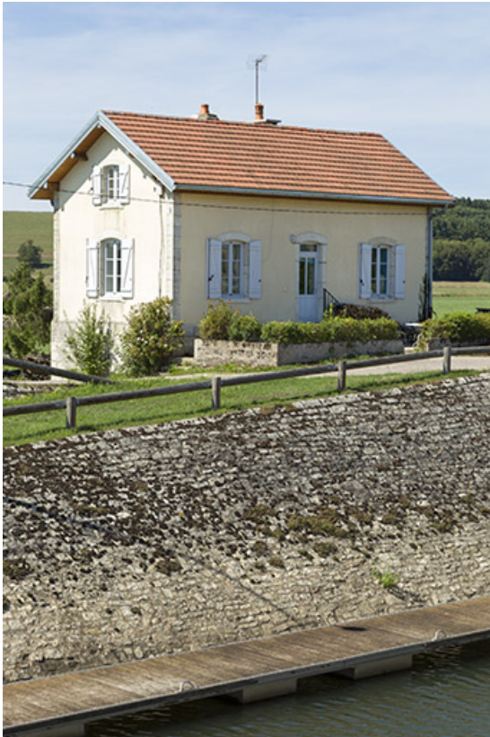
La maison de l'éclusier.
