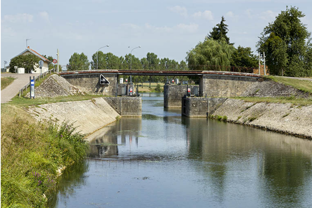
Entrée aval de l'écluse.
