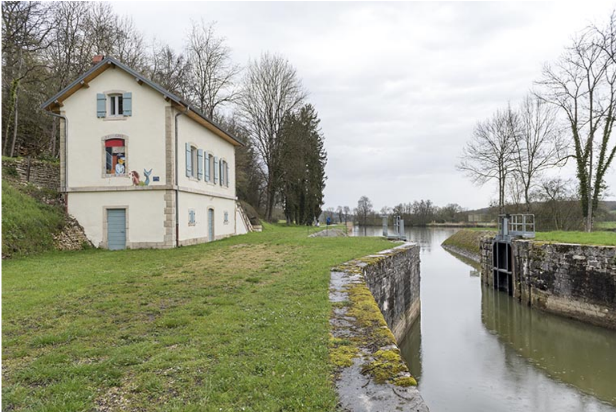
Vue depuis l'aval du site d'écluse.
