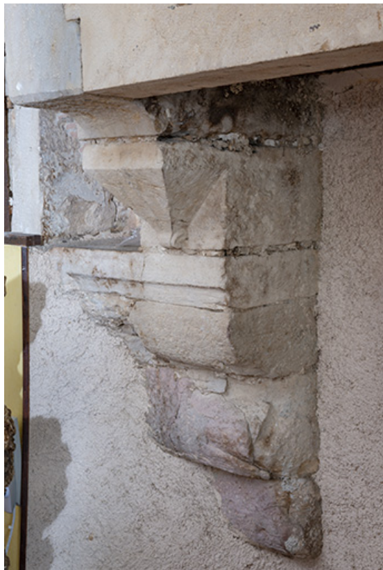
Console supportant la cheminée.
