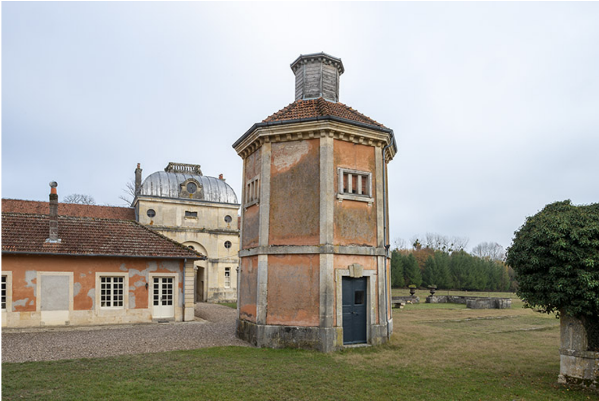
Pigeonnier, vue depuis le nord-ouest.
