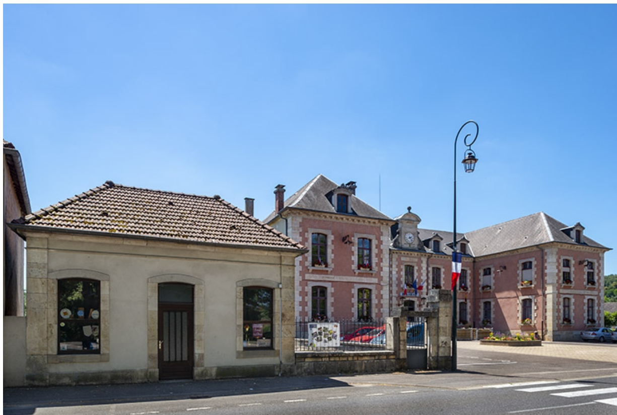
Corps de garde, sur l'avenue des Pâtis.
