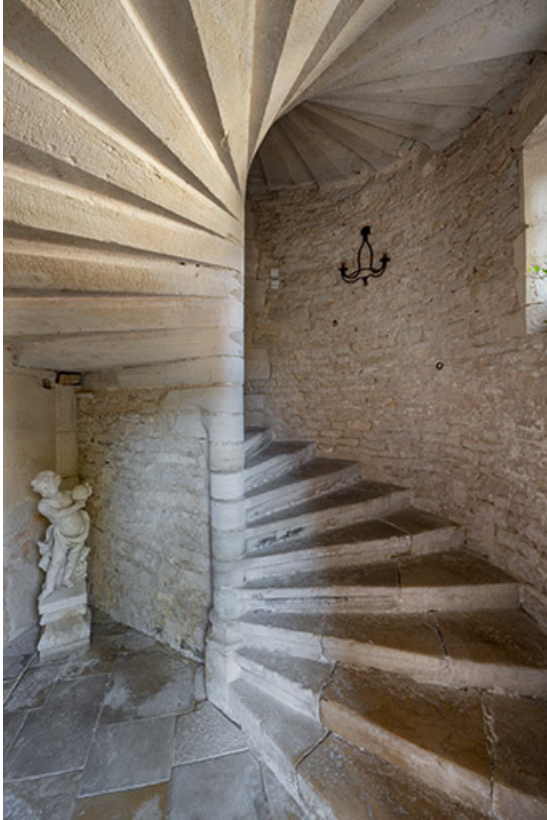
Escalier en vis, rez-de-chaussée.
