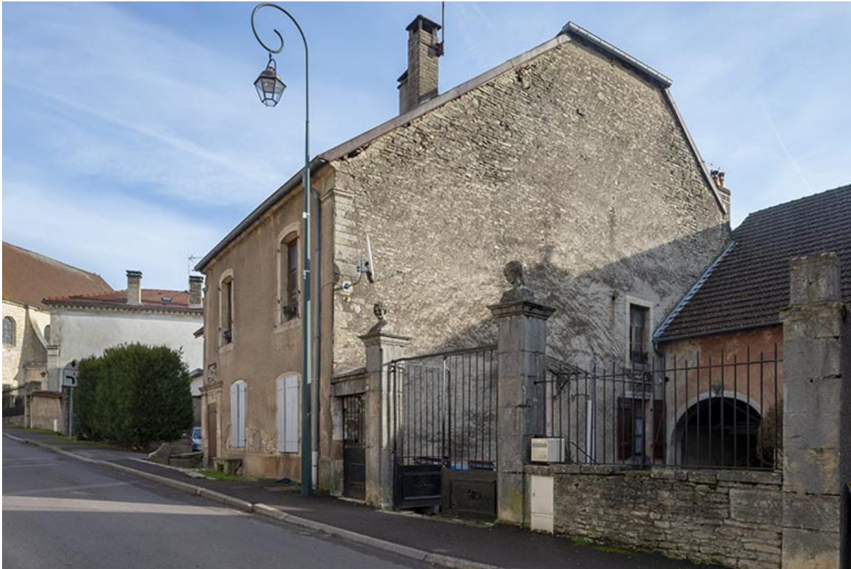
Vue de trois-quart depuis le sud-ouest.
