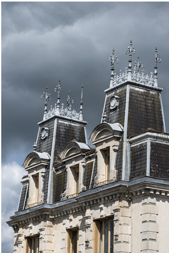
Toiture, côté sud.
