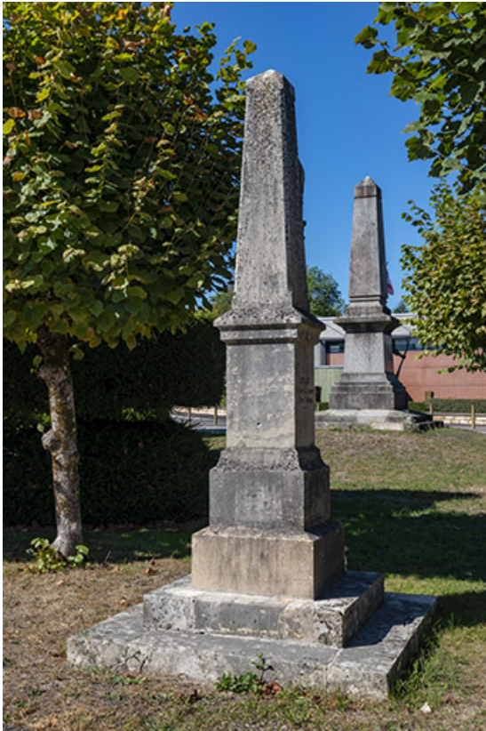
Vue depuis le sud-est.
