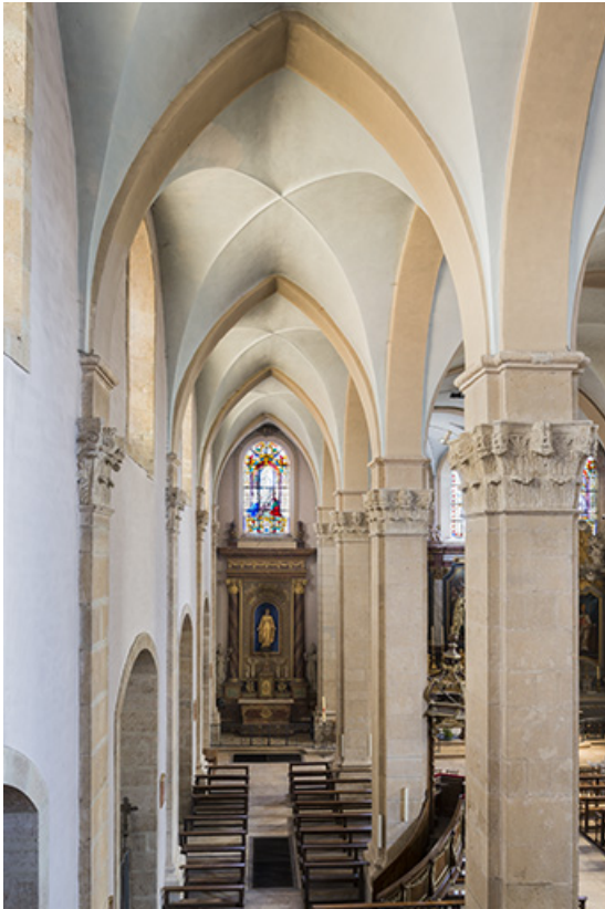
Bas-côté nord, vue en direction du chœur.
