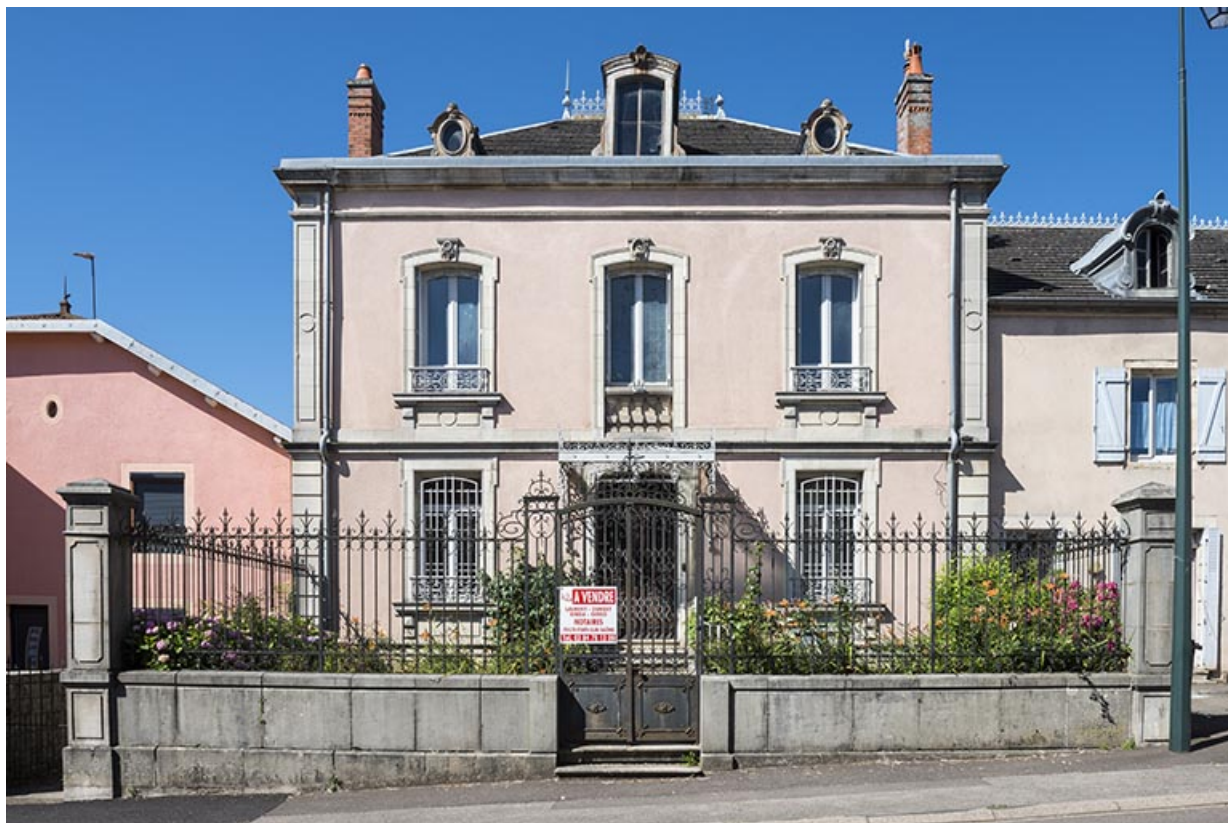
Vue d'ensemble de façade antérieure.
