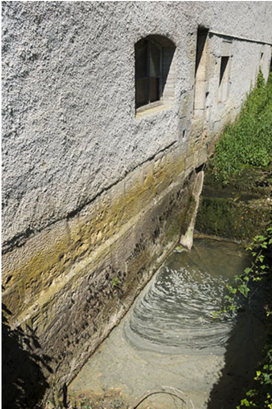
Élévation sur le ruisseau, détail.
