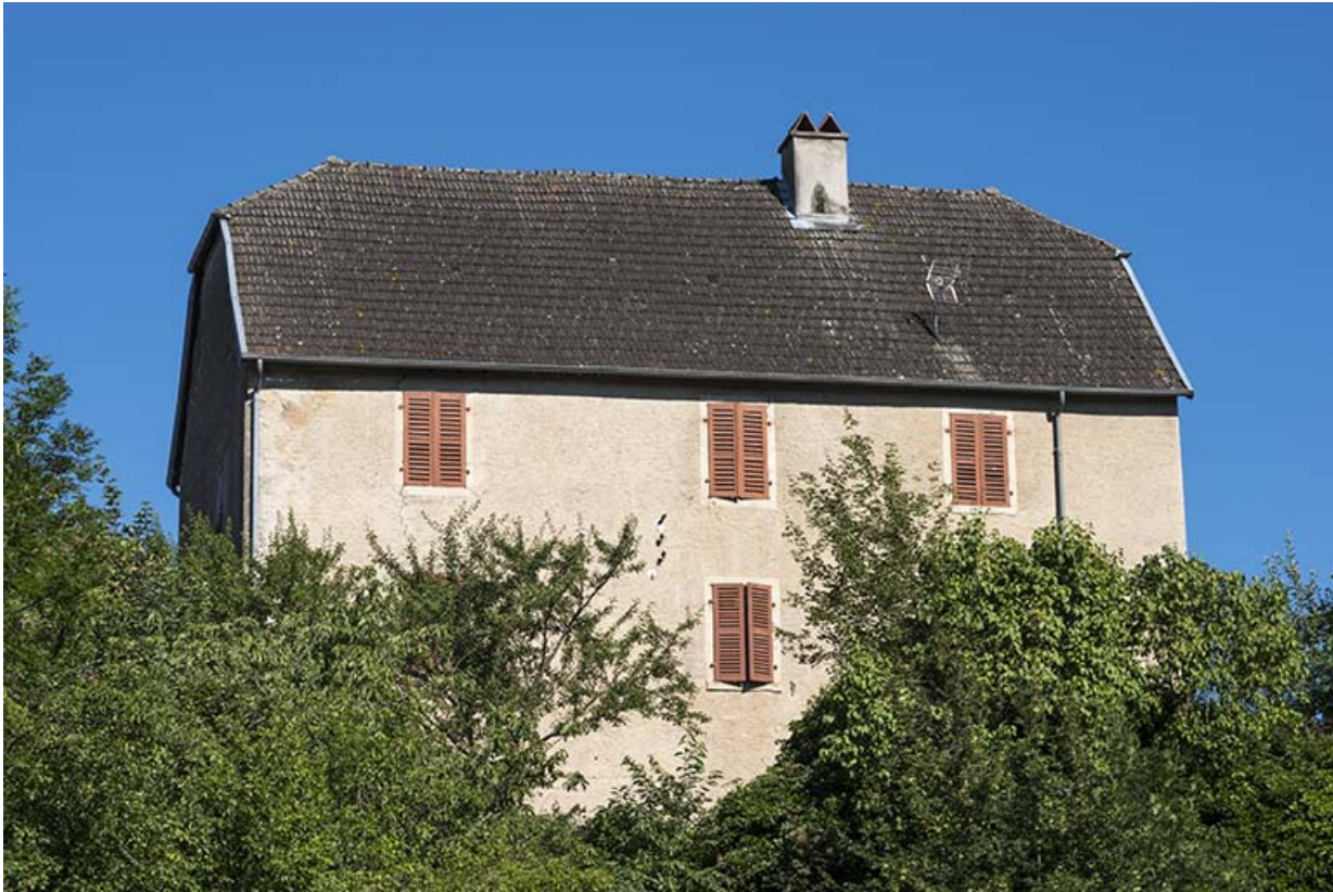
Etages supérieurs de la façade postérieure.
