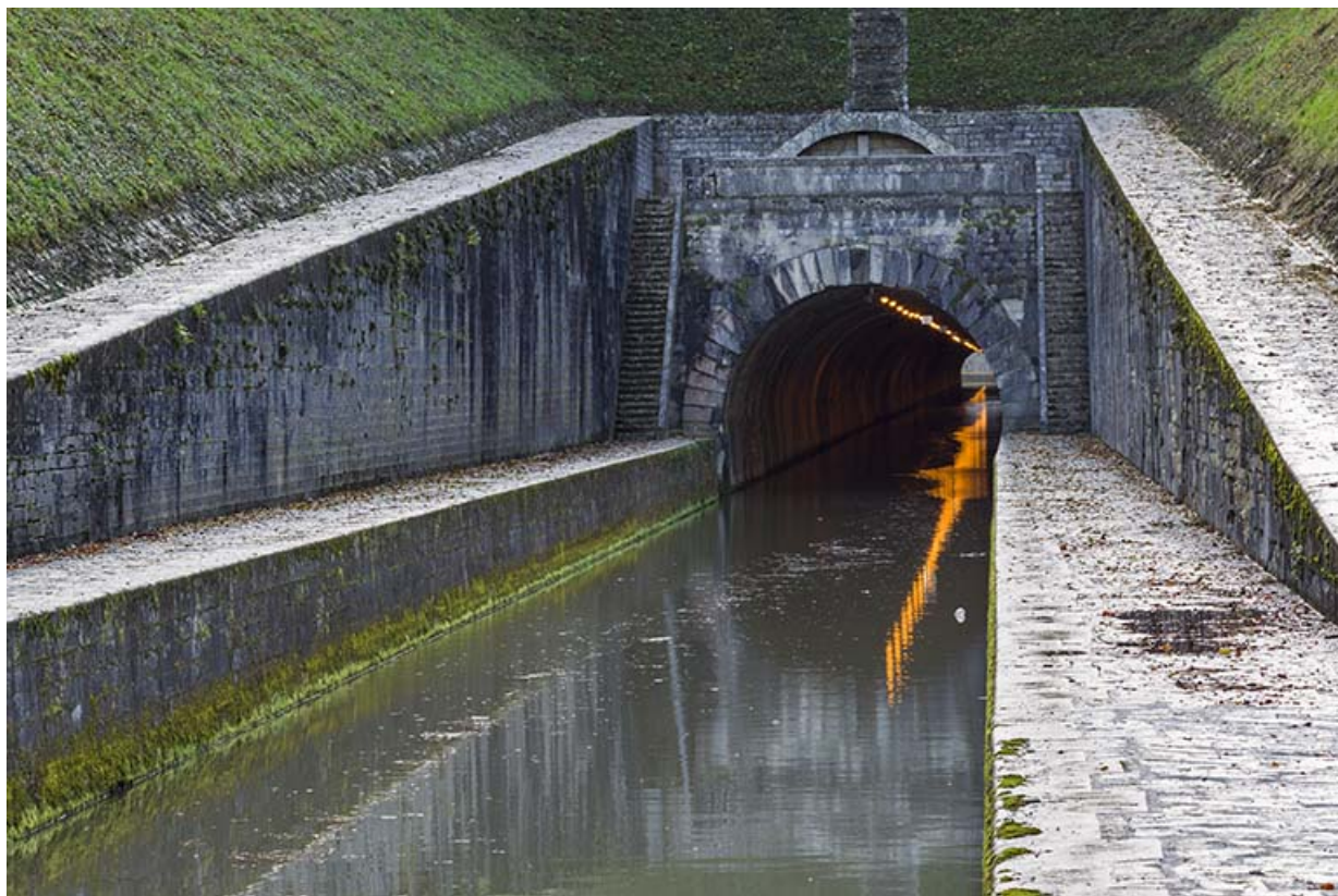
Le tunnel de Saint-Albin.
