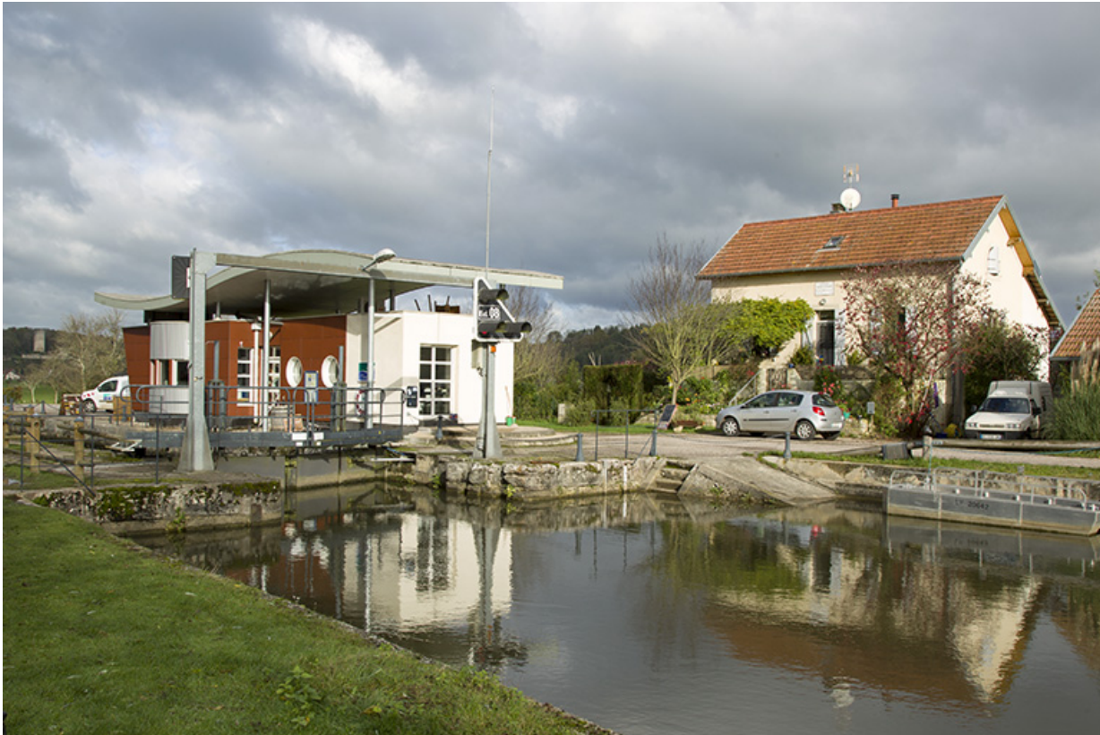
Vue générale de l'ouvrage.
