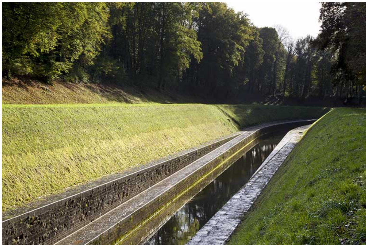
Le canal, vue aval.
