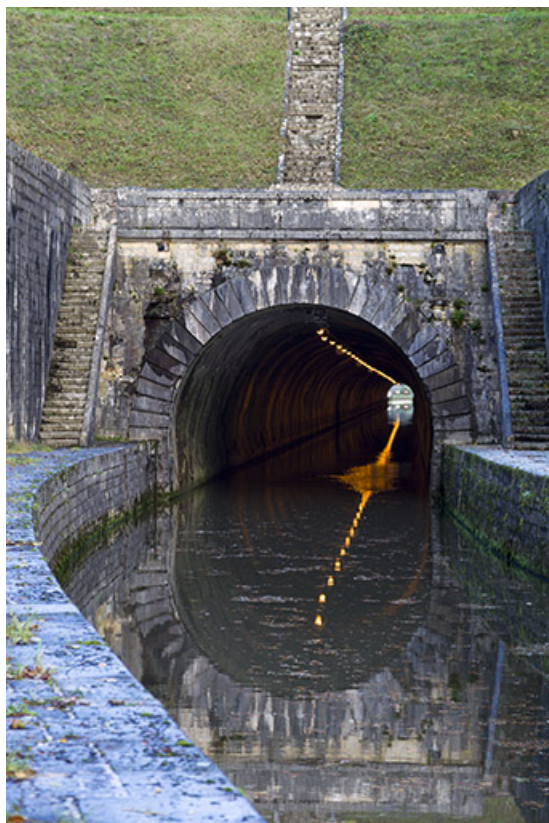
Le tunnel depuis l'aval.
