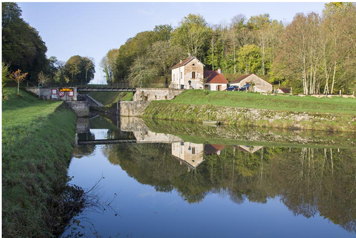
Entrée du canal depuis l'amont.
