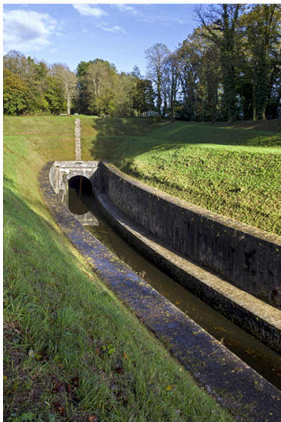
Entrée du tunnel depuis l'aval.
