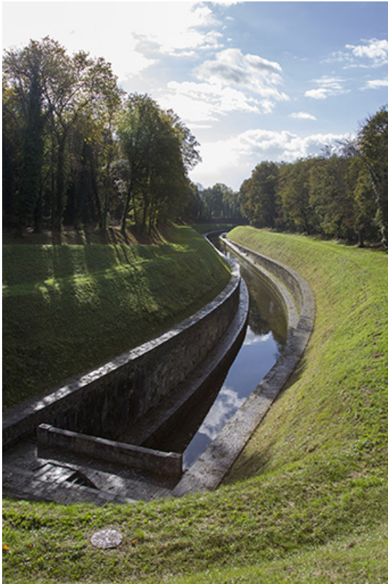
Le canal en aval.
