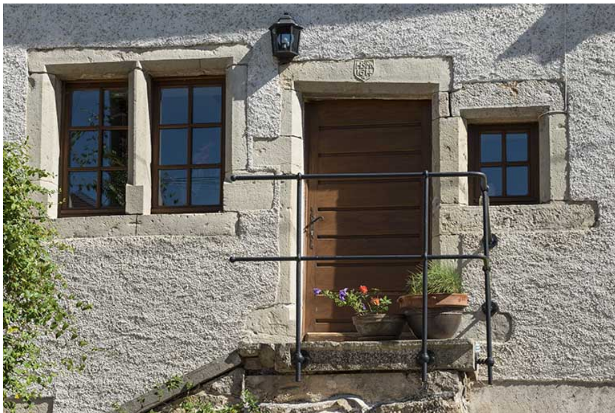
Les ouvertures au niveau de l'étage carré.
