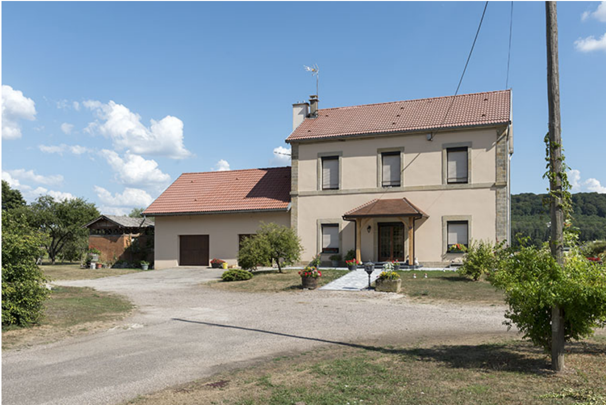
Façade antérieure de l'ancienne gare.
