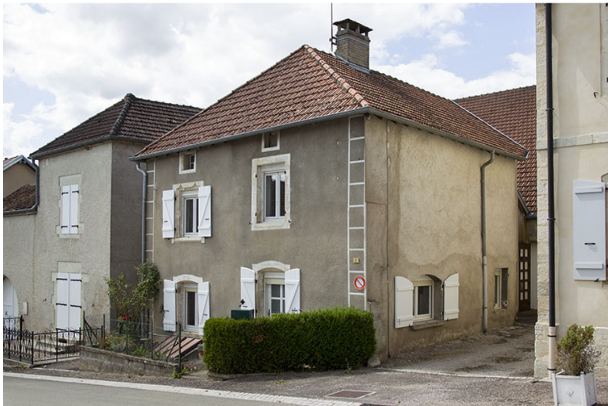
Vue générale de trois quart droite.
