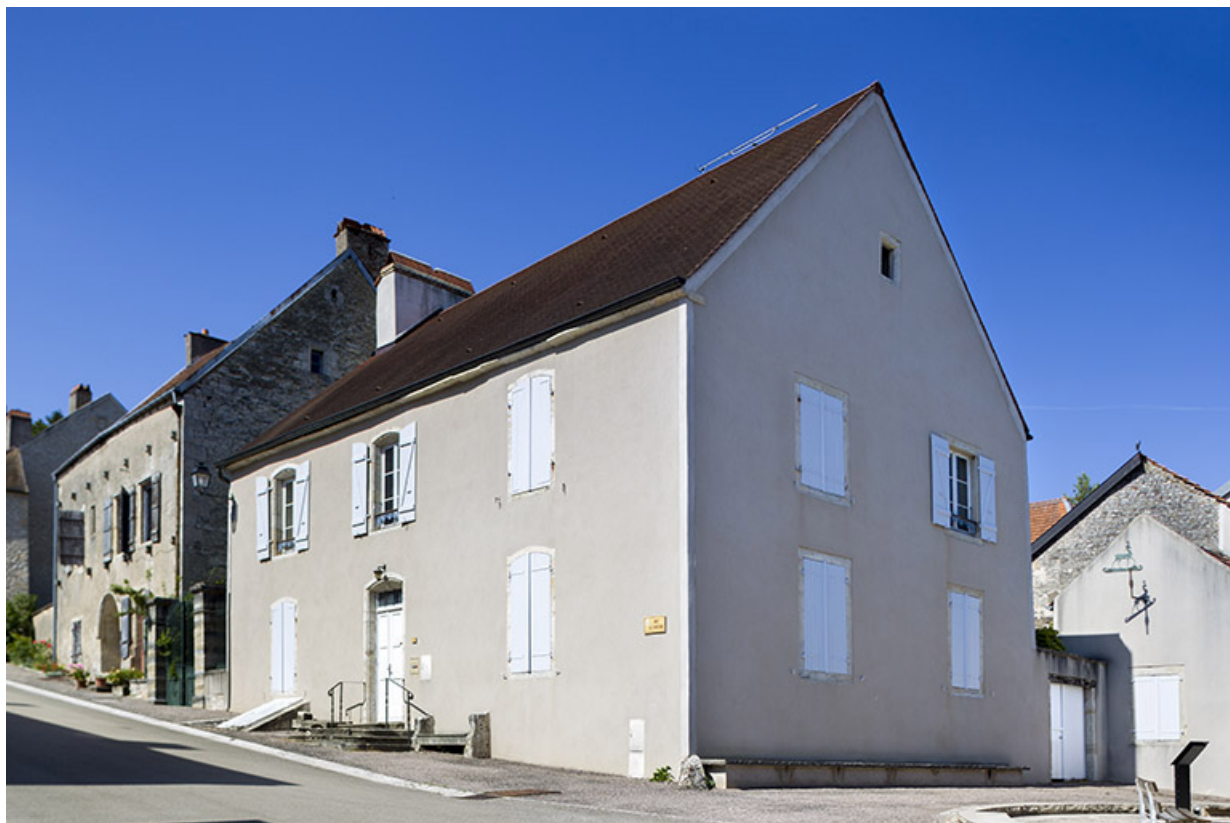
Vue générale de trois quart droite.
