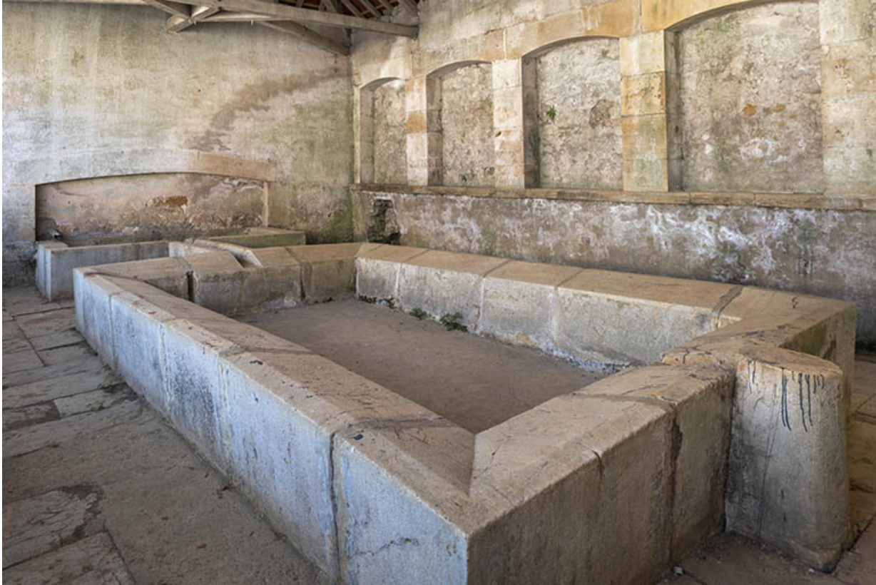
Le bassin du lavoir.
