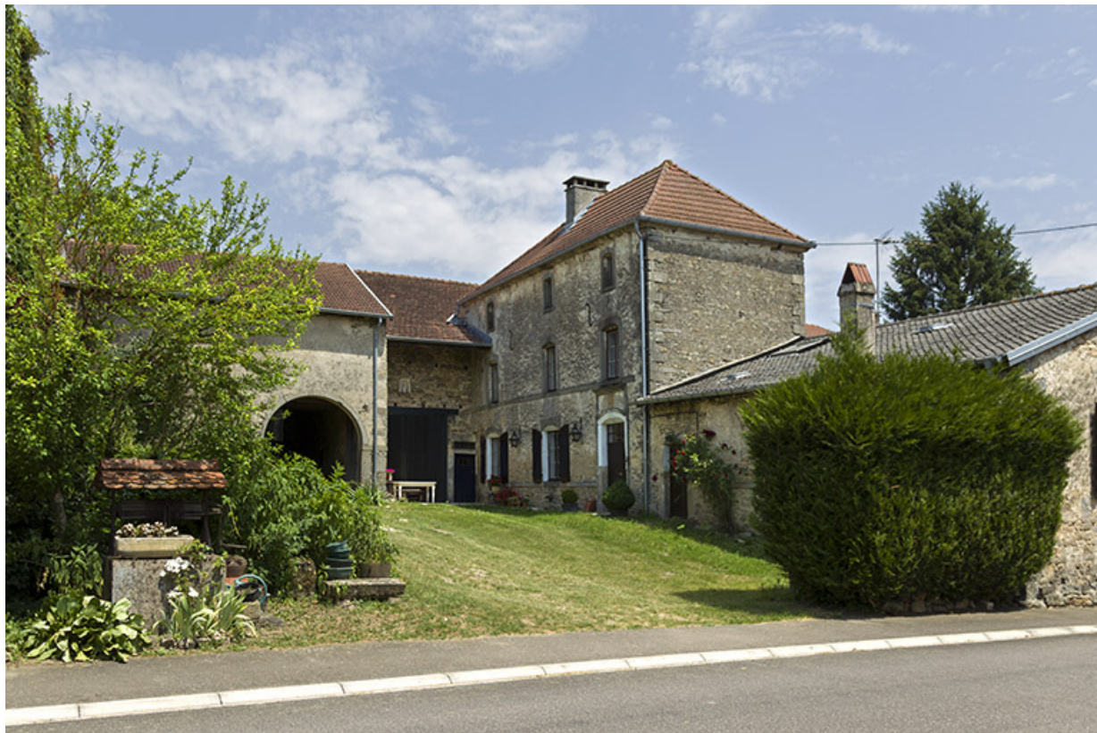
Maison et ferme, 11 rue des Marronniers. 70, Vougécourt
