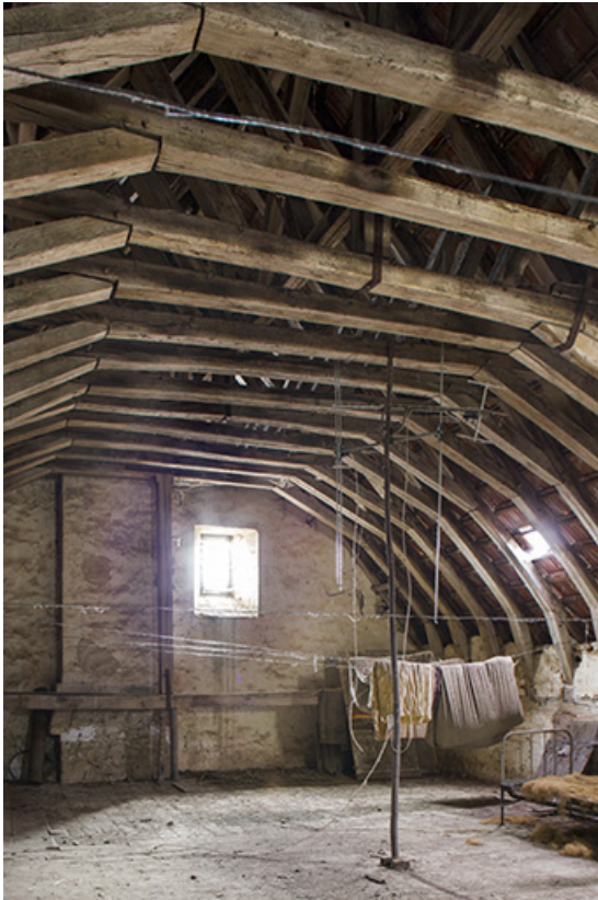
Vue rapprochée de la charpente.
