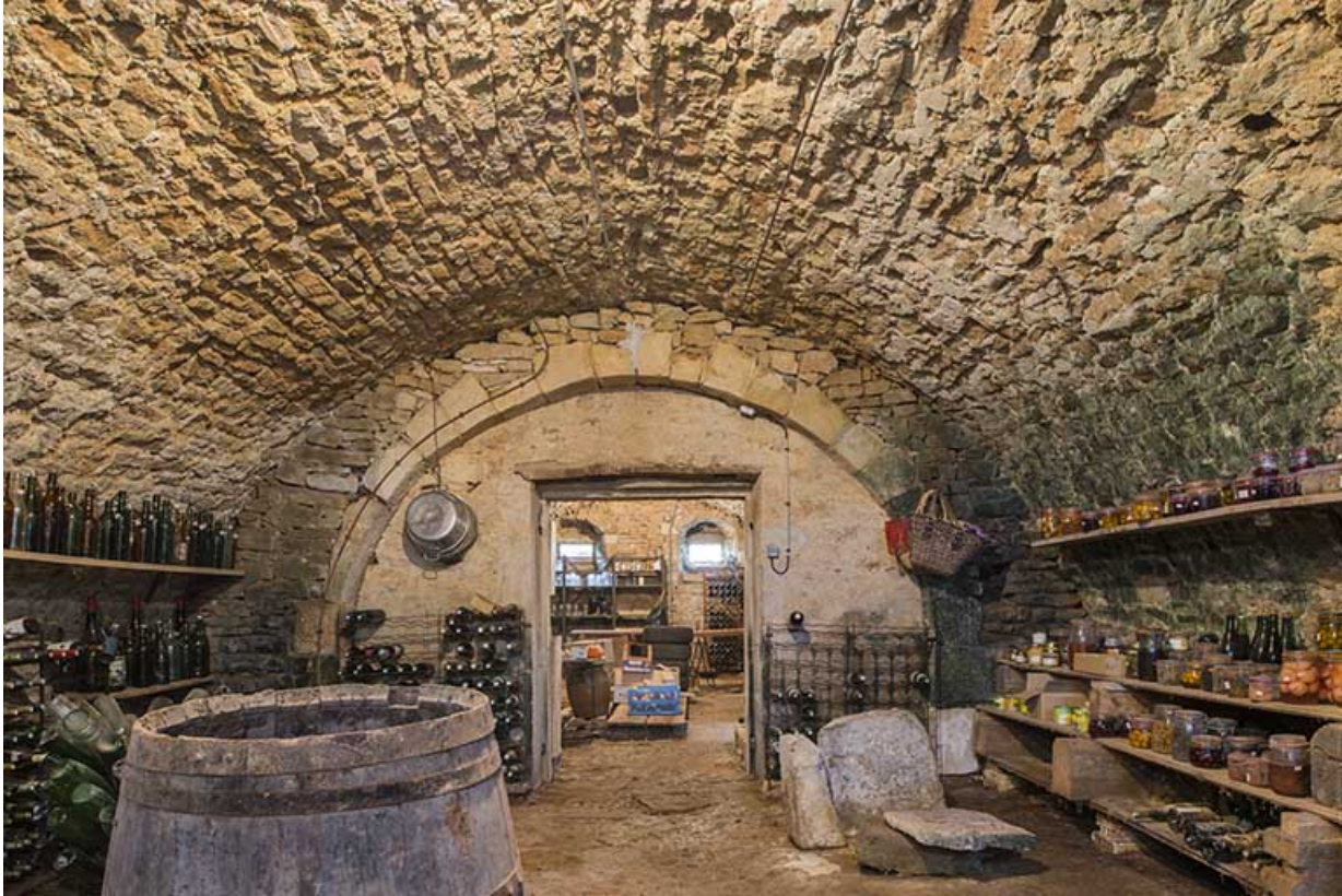
La cave voutée, vue générale.
