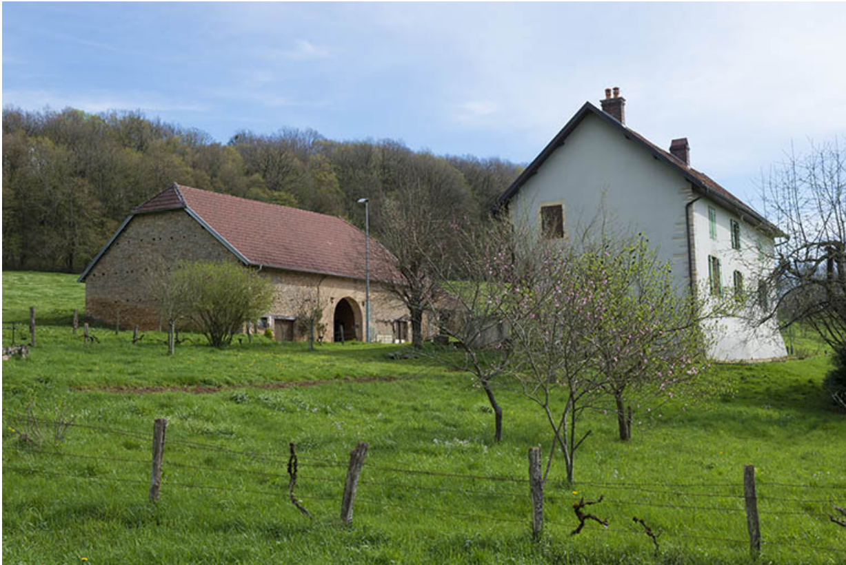
Vue depuis l'ouest.
