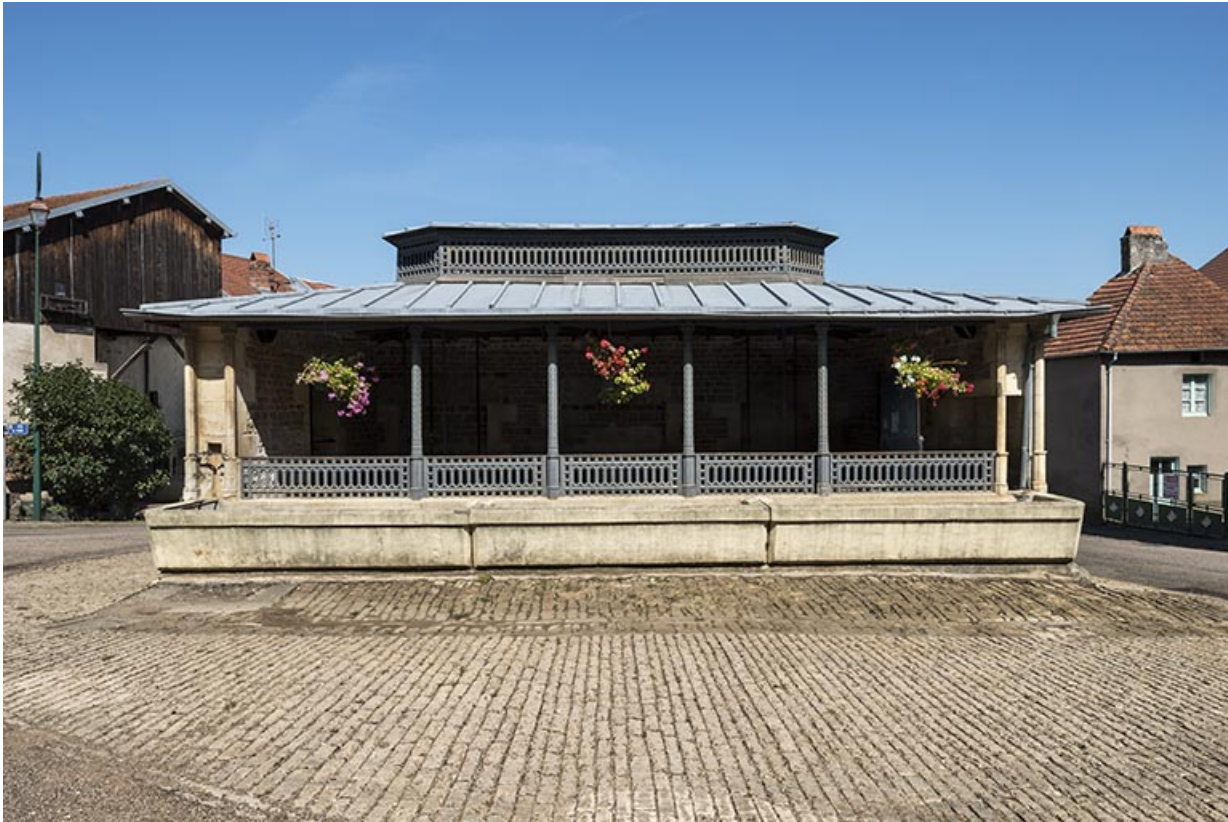
La façade antérieure de l'édifice.
