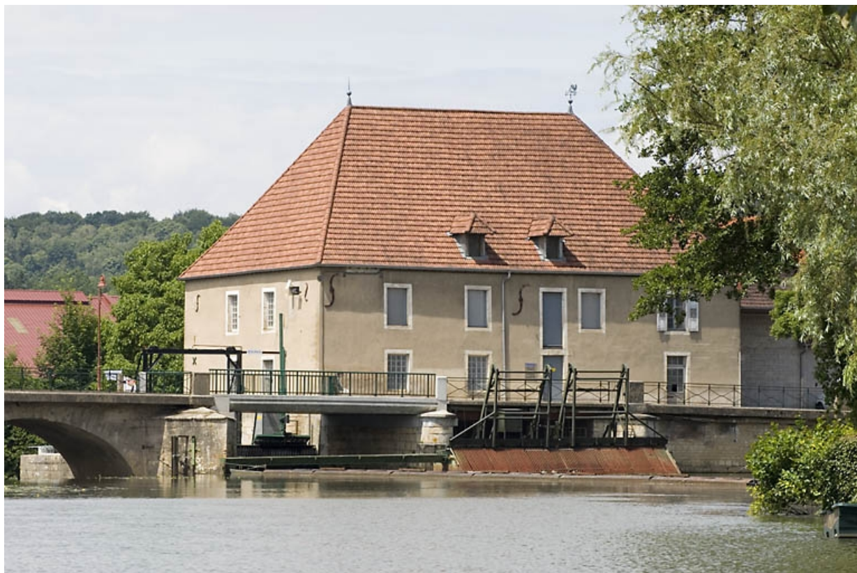
Vue d'ensemble en amont de la Saône.
