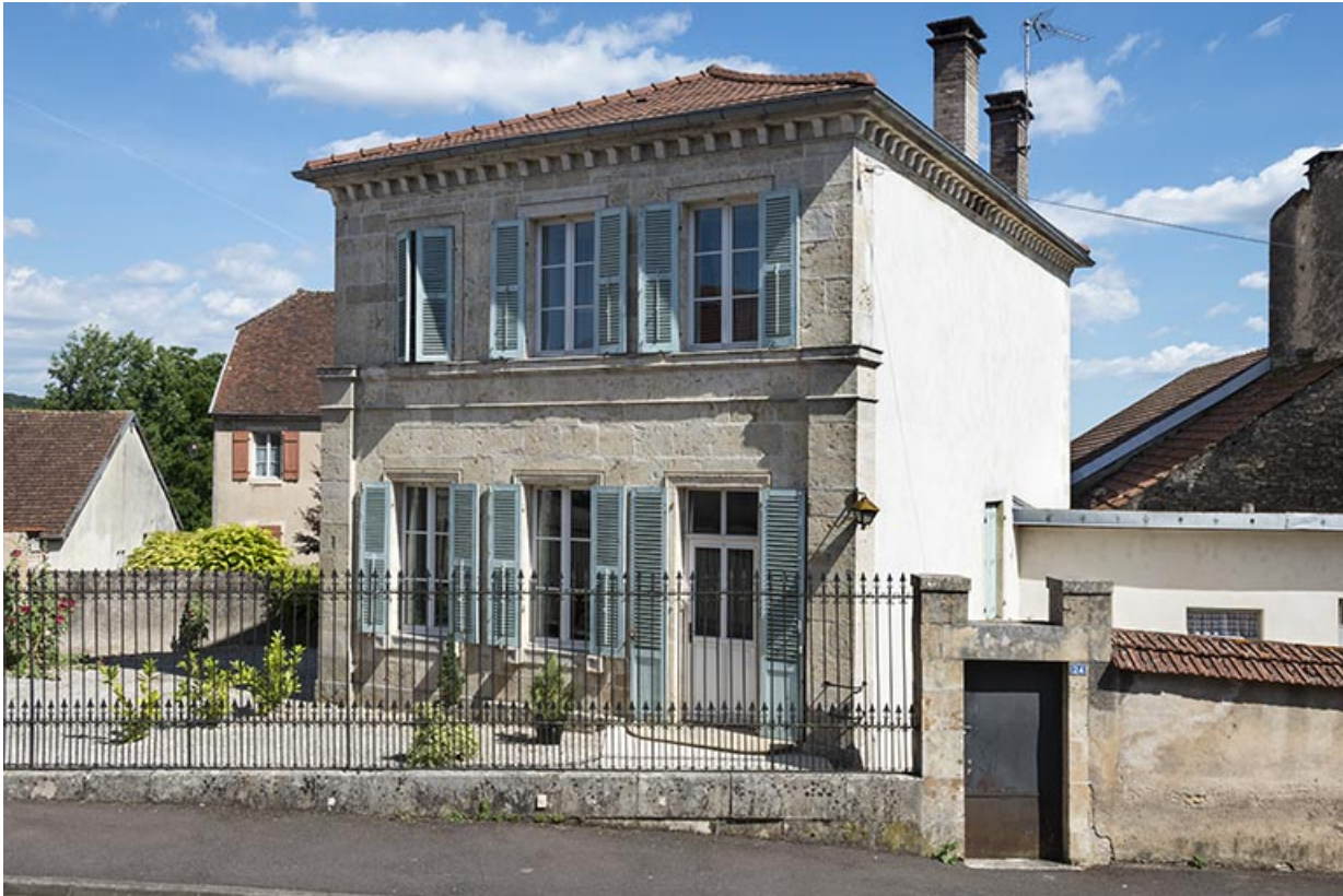
Ancienne école des filles, quartier de l'église.
