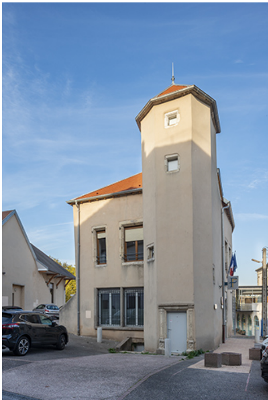
Détail de la tour d'escalier.
