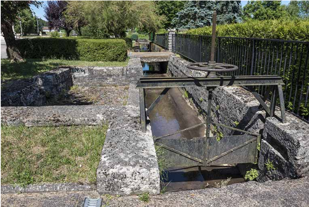
Détail de la vanne située en aval sud de la remise de matériel d'incendie et d'un lavoir en pierre. 70, Ferrières-lès-Scey
