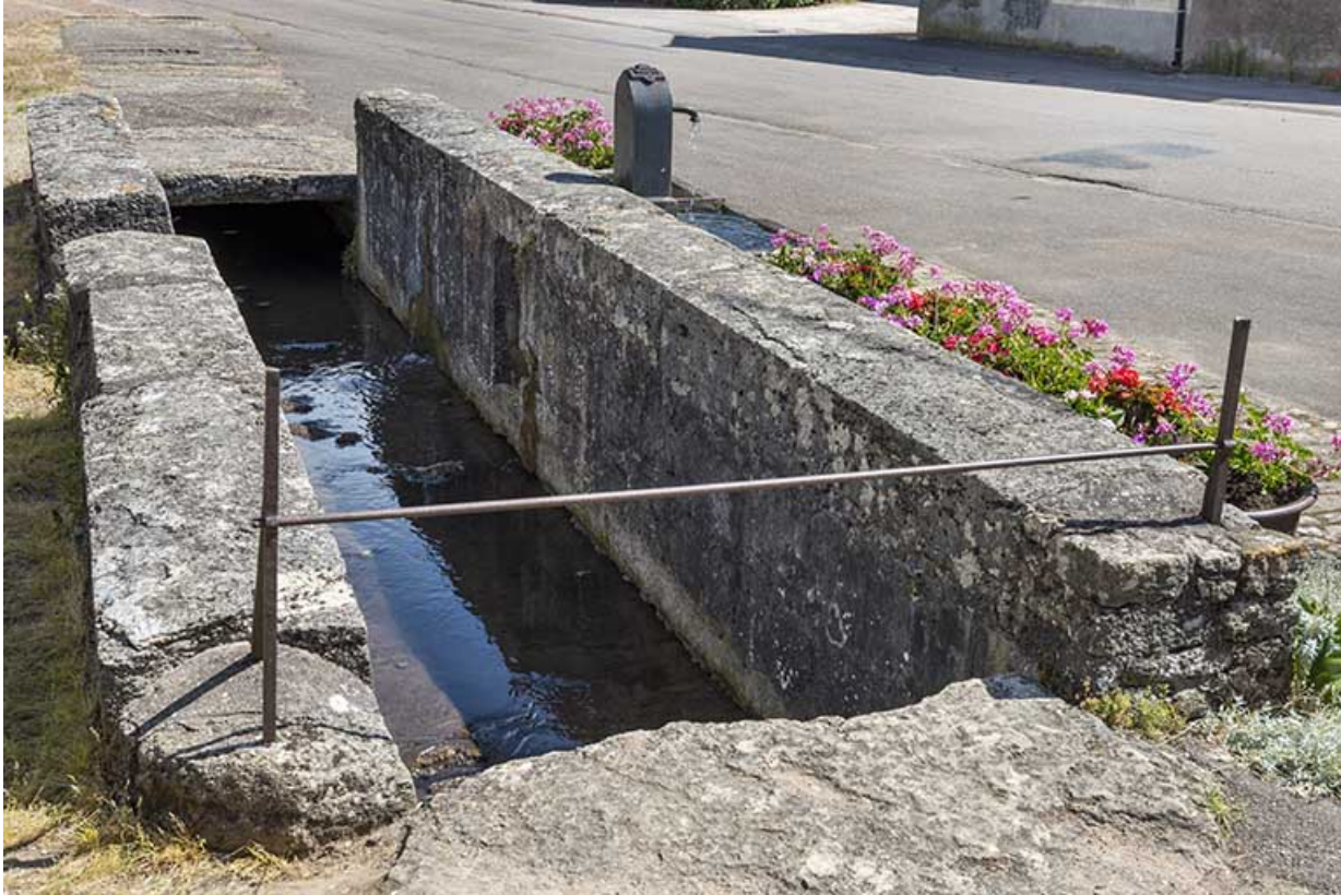
Le ruisseau canalisé alimentant les bornes fontaines.
