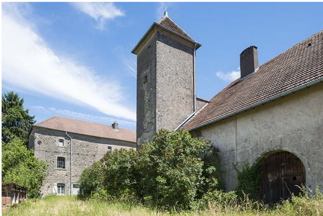
Vue générale sud-ouest du corps de bâtiment.
