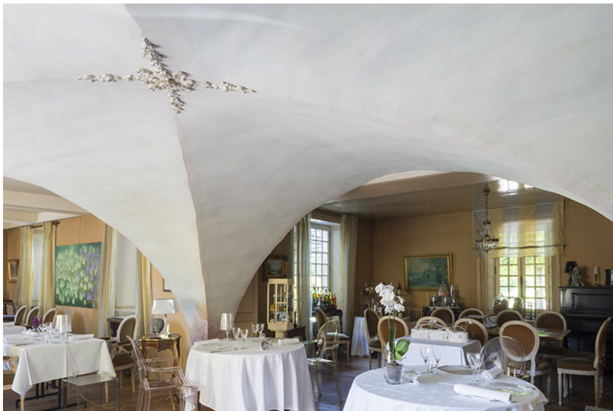
Détail au niveau de la croisée.
