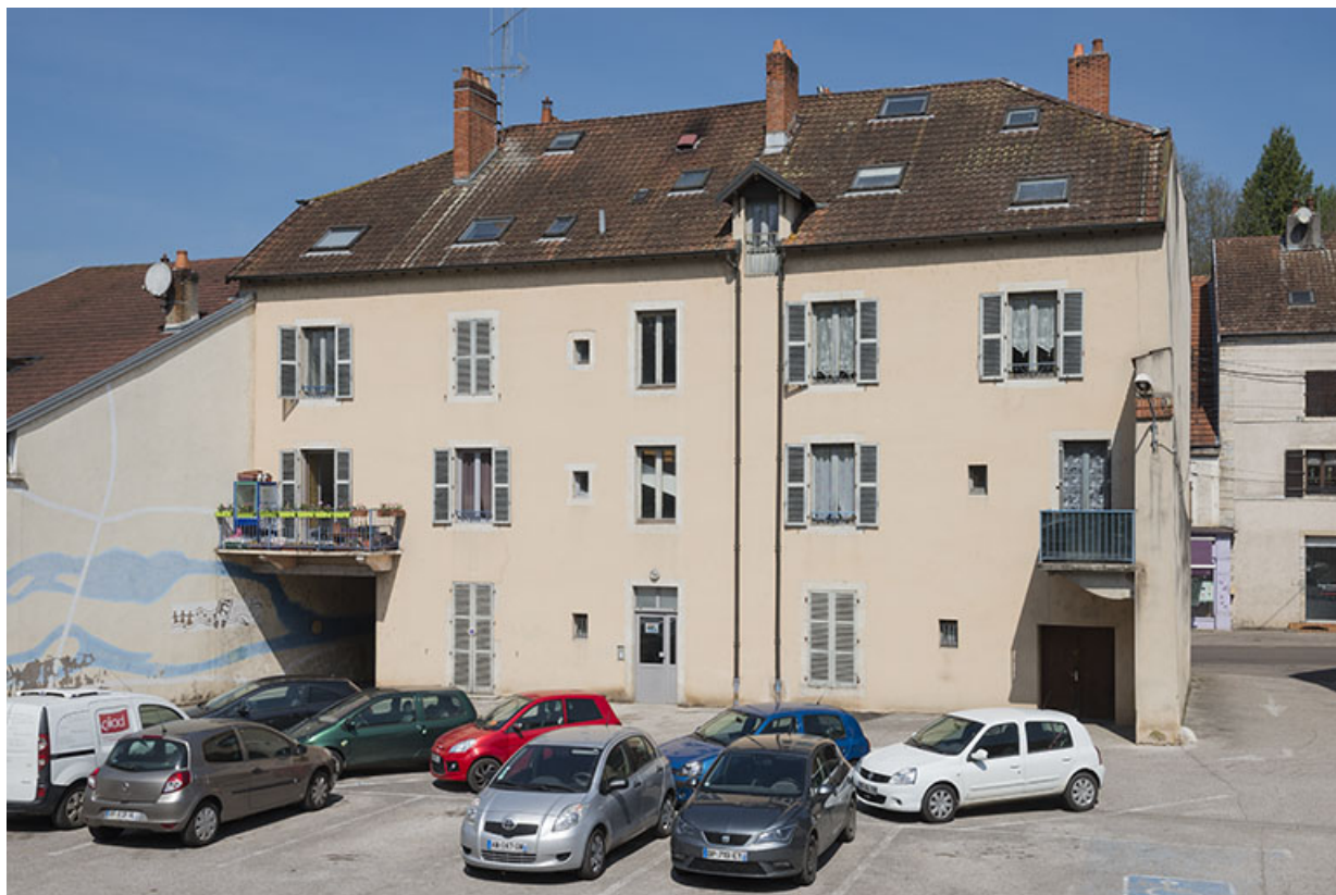
La cour et la façade postérieure.
