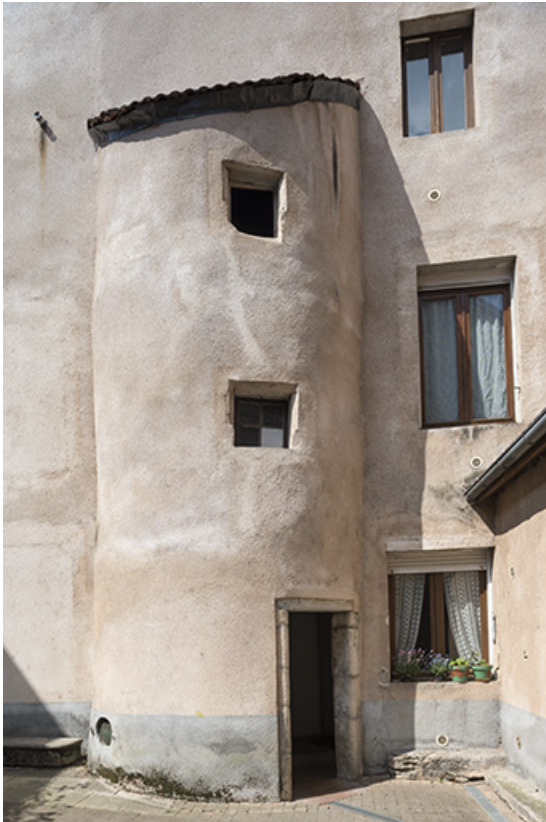
Tour comprenant un escalier, cour intérieure.
