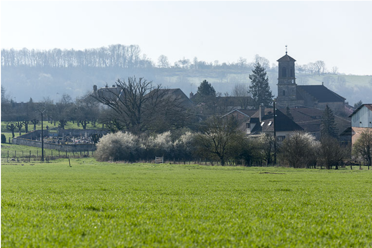
Vue du Grand-Magny depuis le nord-ouest.
