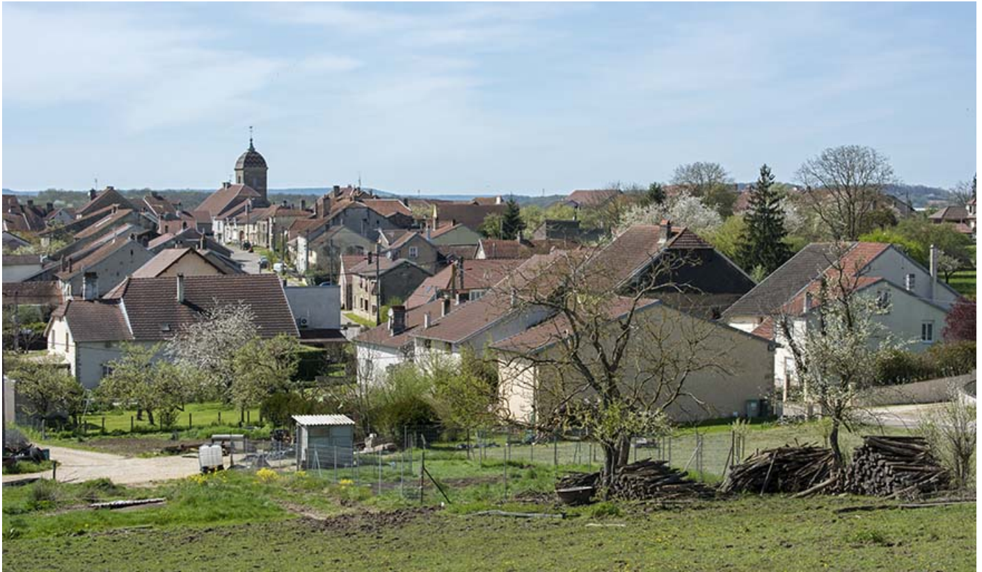
Vue d'ensemble du village depuis l'est. 70, Cendrecourt
