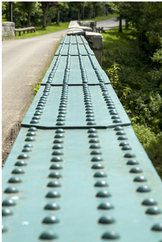
Détail de la rambarde de la passerelle.
