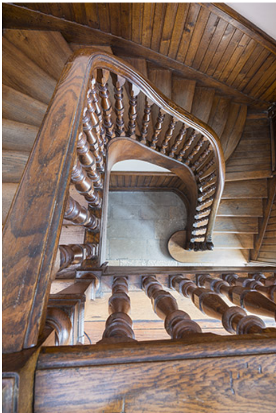
L'escalier à deux quart tournant.
