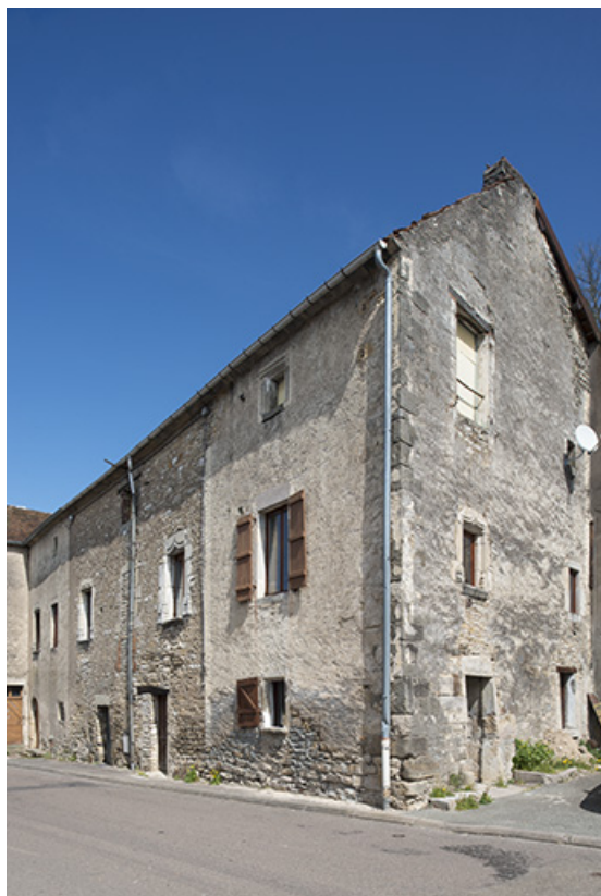
Vue de détail sur les ouvertures.
