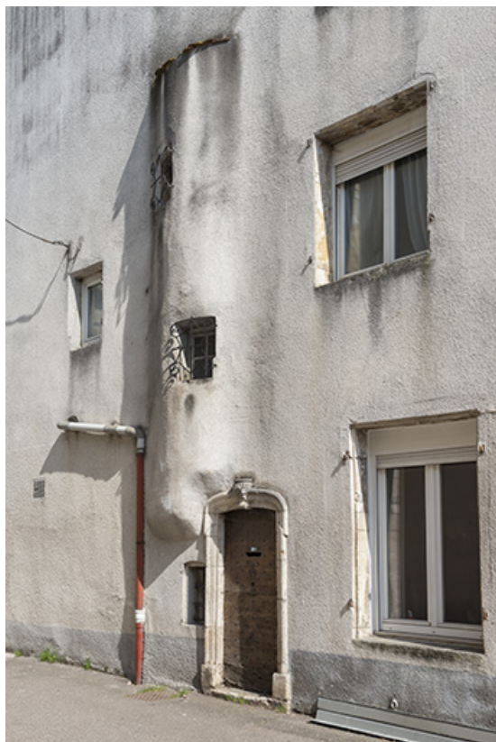
Maison à tour, rue Jean Bogé.
