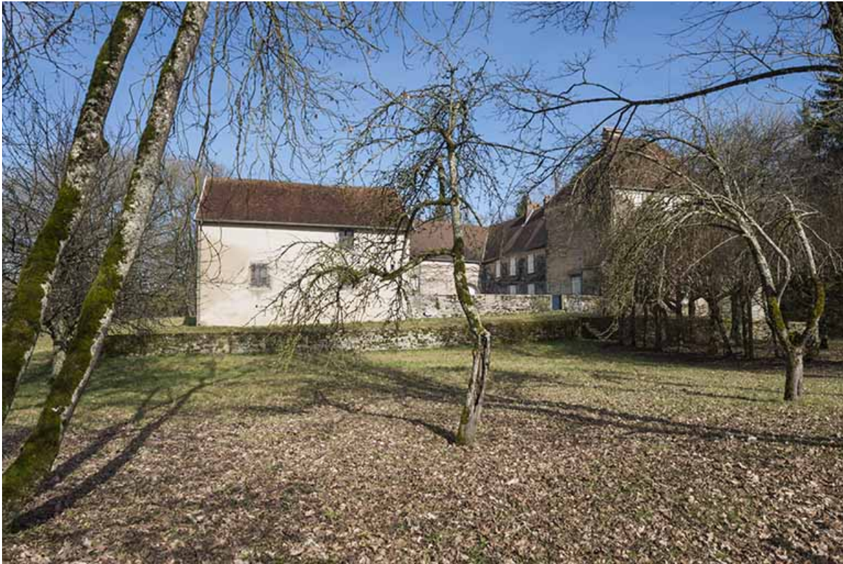
Vue Sud du château.
