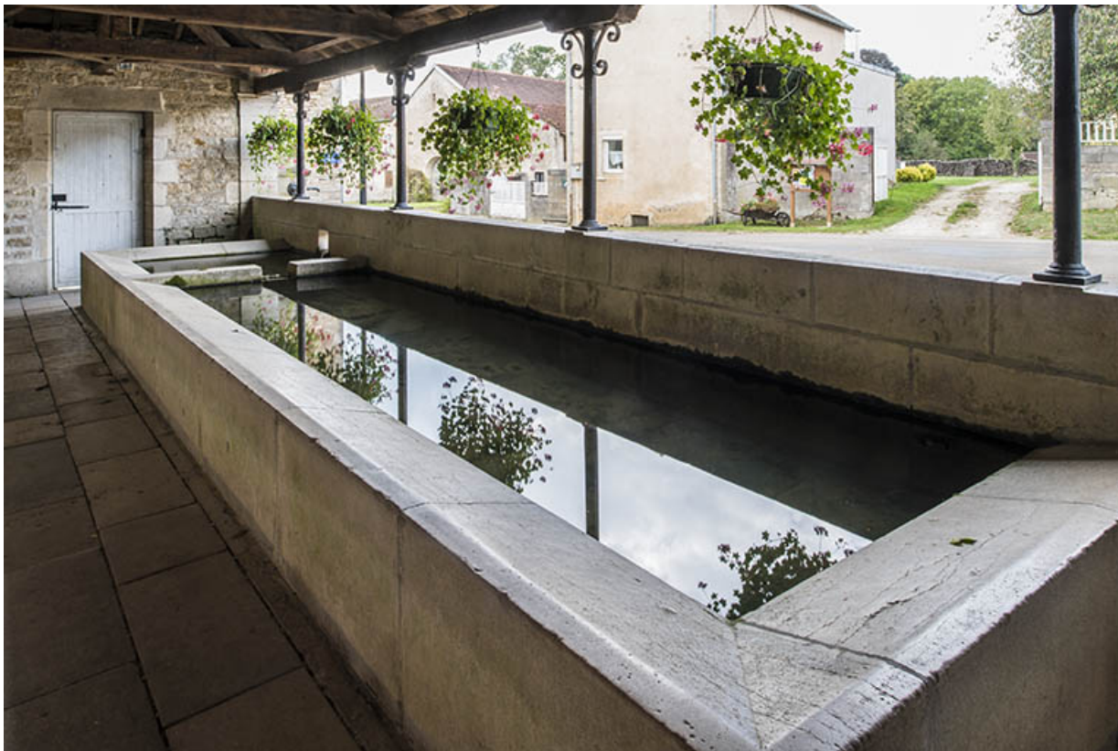
Le bassin à usage de lavoir.
