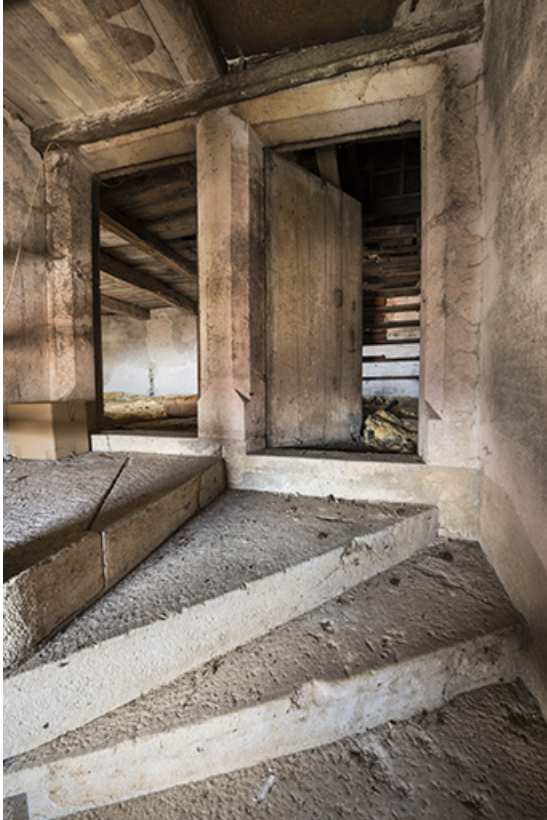
Portes d'accès aux combles depuis la tour.
