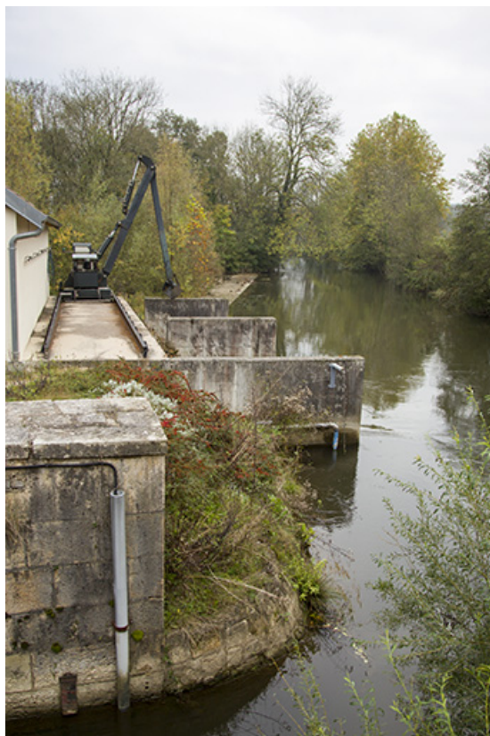
Appareil lié à l'entretien du canal.
