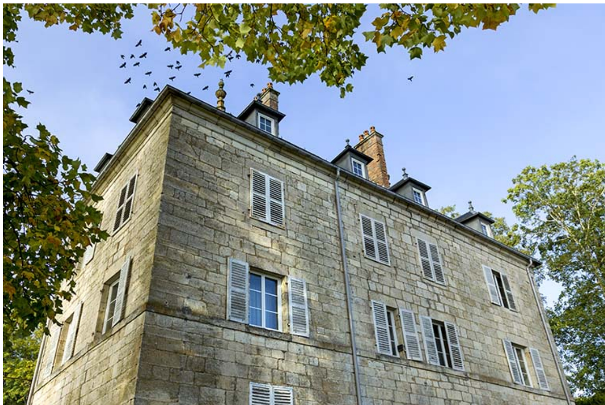
Façade postérieure et façade latérale droite.
