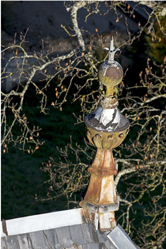
Détail : un des épis de faîtage.
