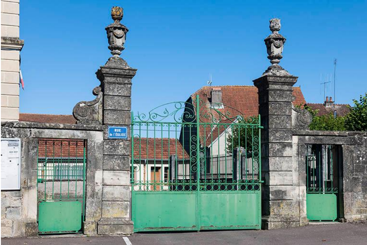
Portail d'entrée de la mairie.
