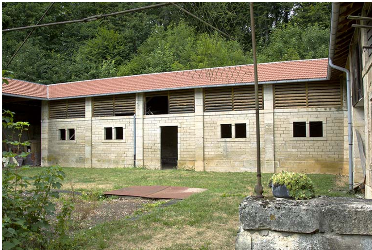
Vue générale de la bergerie, aile nord-ouest.
