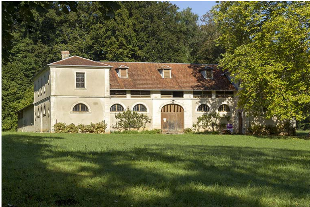
Vue générale de la façade sud-est.
