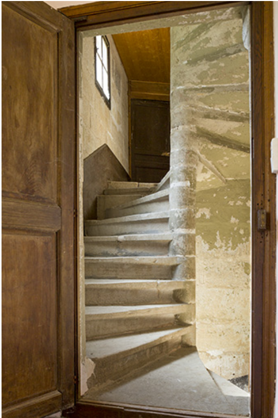
Escalier en vis.
