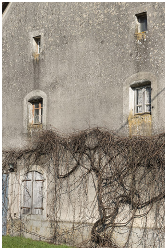
Détail des baies.
